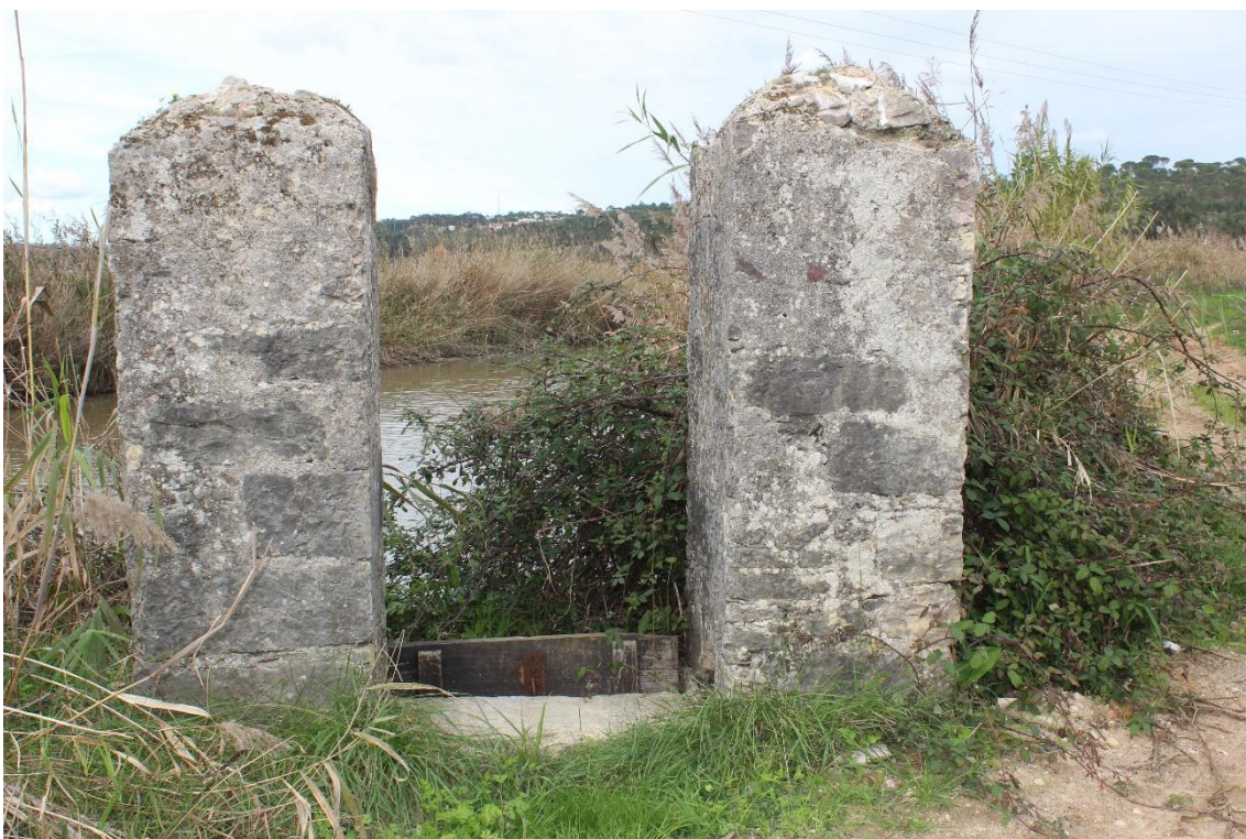
Figura 2 – Os dois pilares sendo visível a porta de água.
