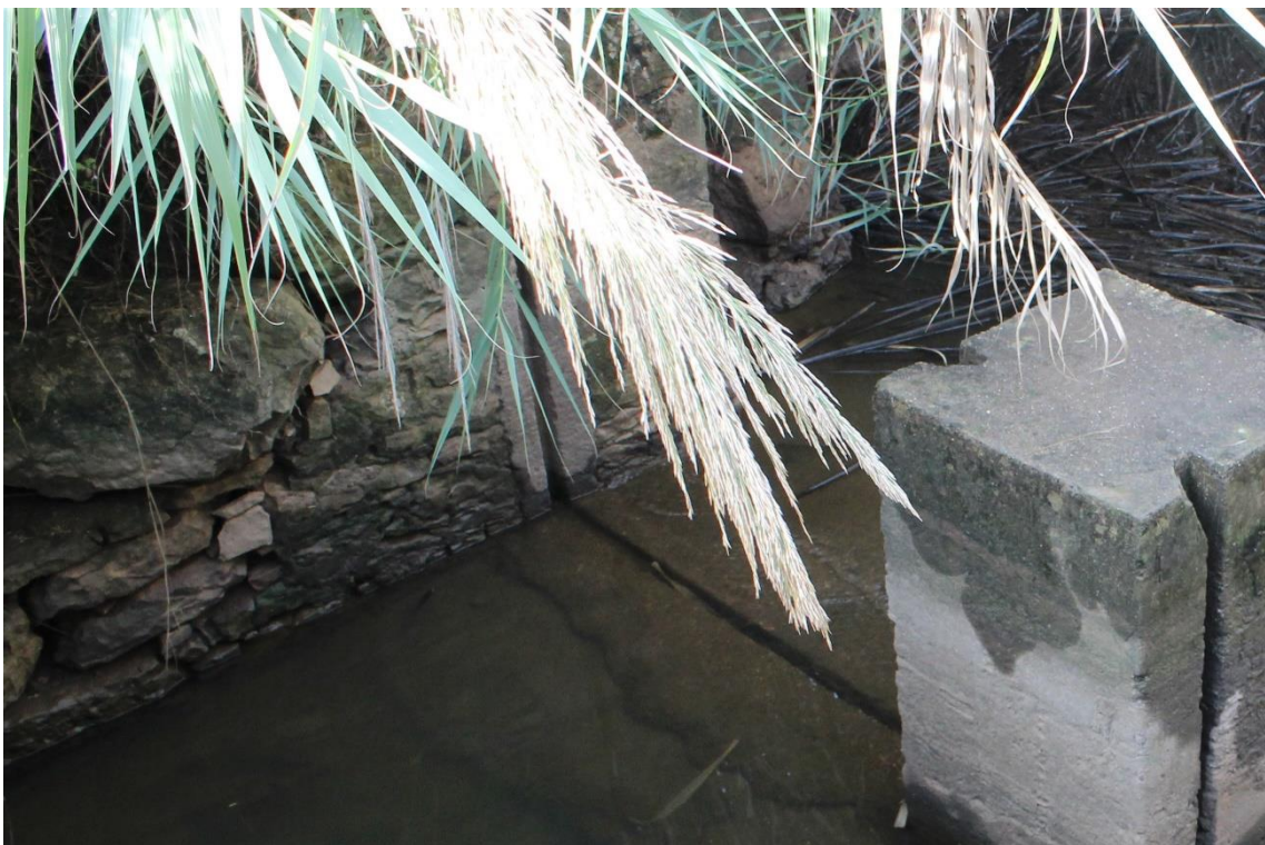
Figura 3 – Pormenor do aparelho da margem com a calha para a porta de água.
