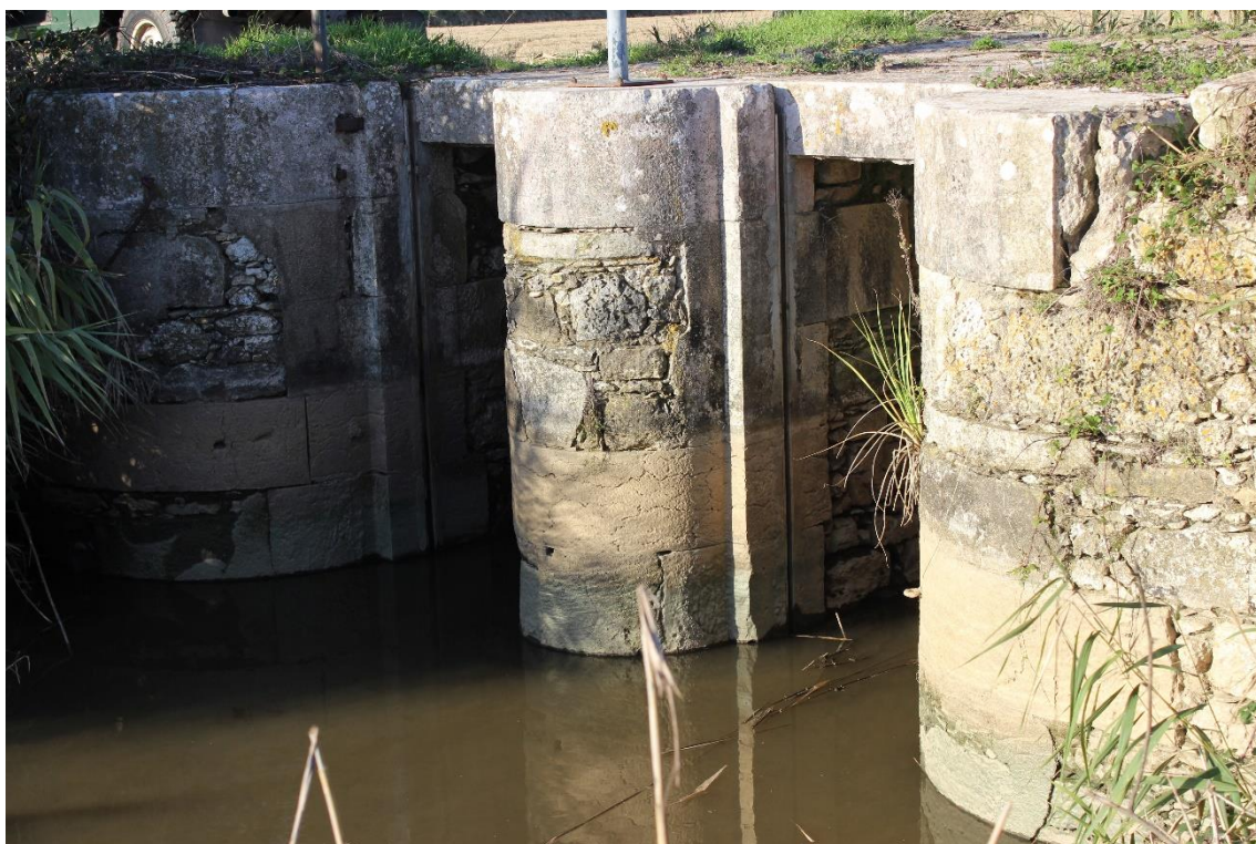
Figura 2 – Pormenor do aparelho e estrutura de duplo cubo.
