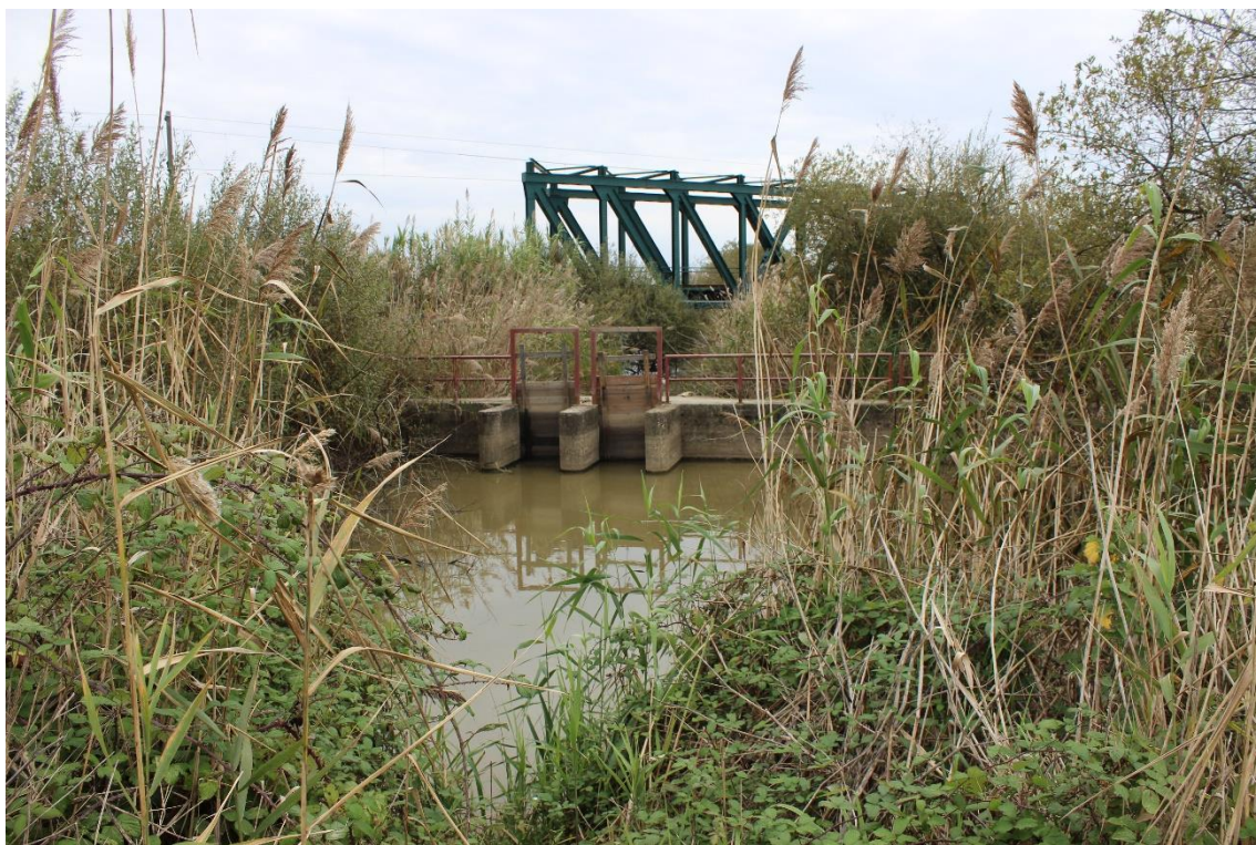
Figura 2 –A atual comporta em funcionamento, junto à via férrea e na proximidade da antiga comporta.
