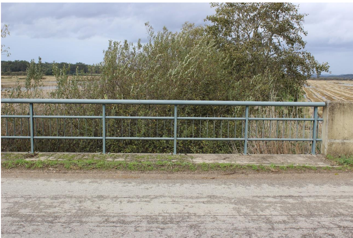
Figura 4 – Vala Real sob o viaduto da M622
