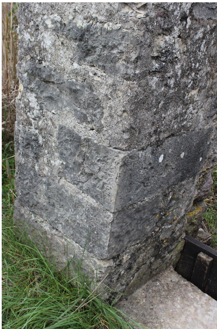
Figura 3 – Pormenor do aparelho e argamassa
