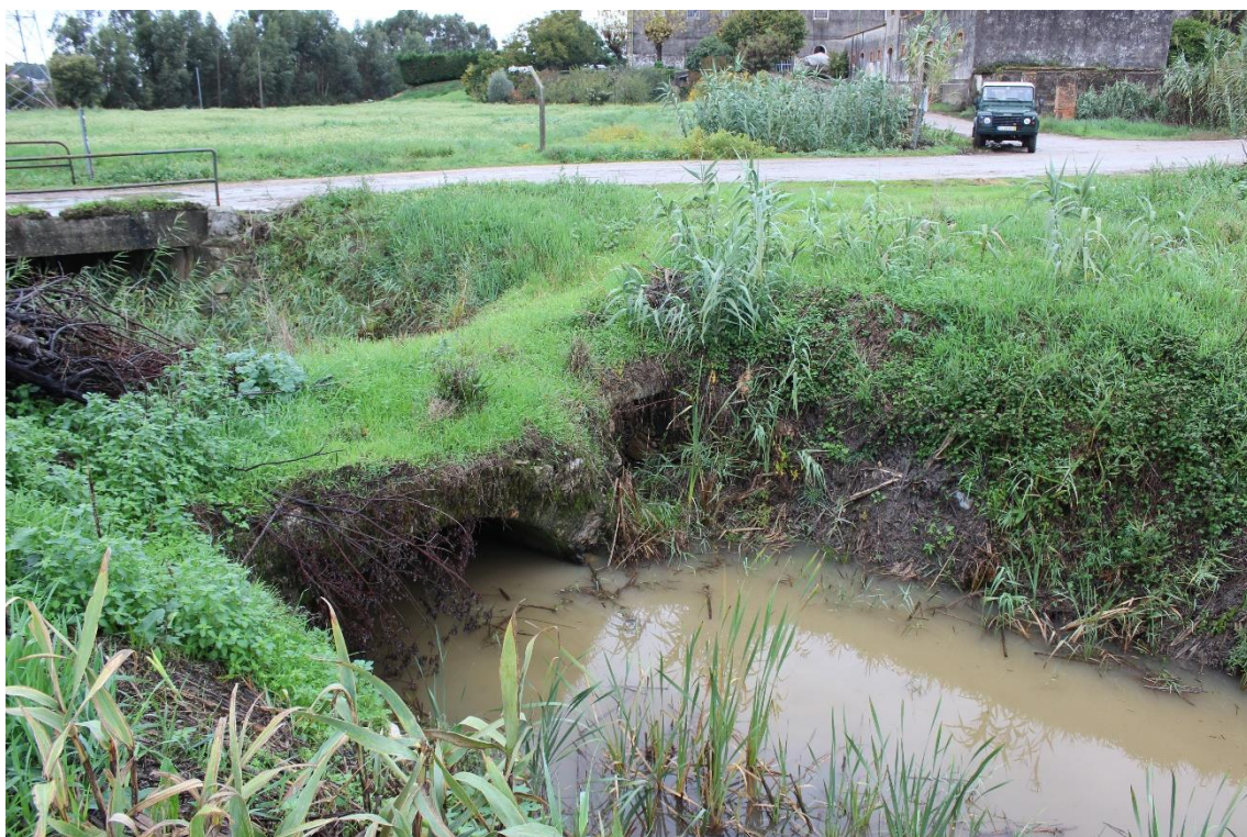
Figura 6 – Ribeira de Queitide/Vala Real(?) com pontão de um arco, junto à Quinta do Seminário.
