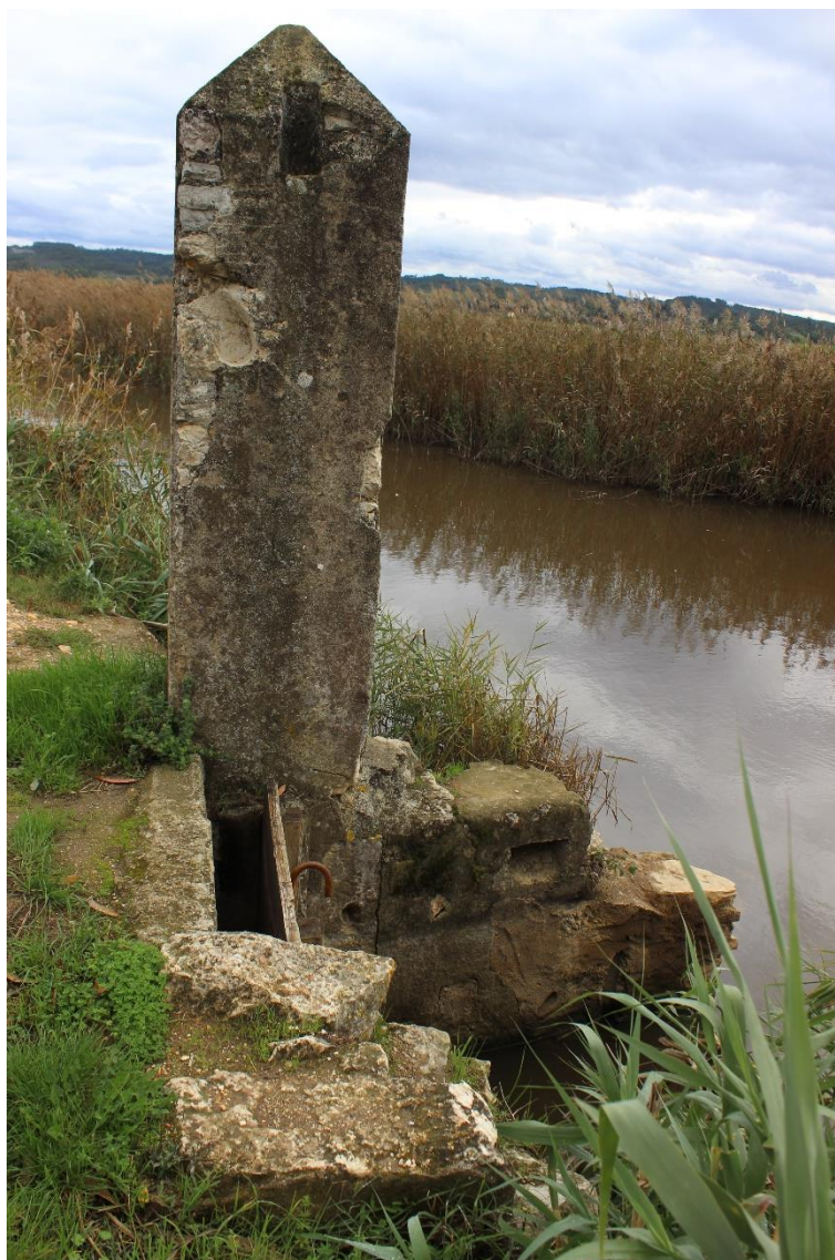
Figura 2 – O cubo encimado pelo pilar conservado e a base do fraturado. Perspetiva que destaca os diversos entalhes na estrutura conservada.
