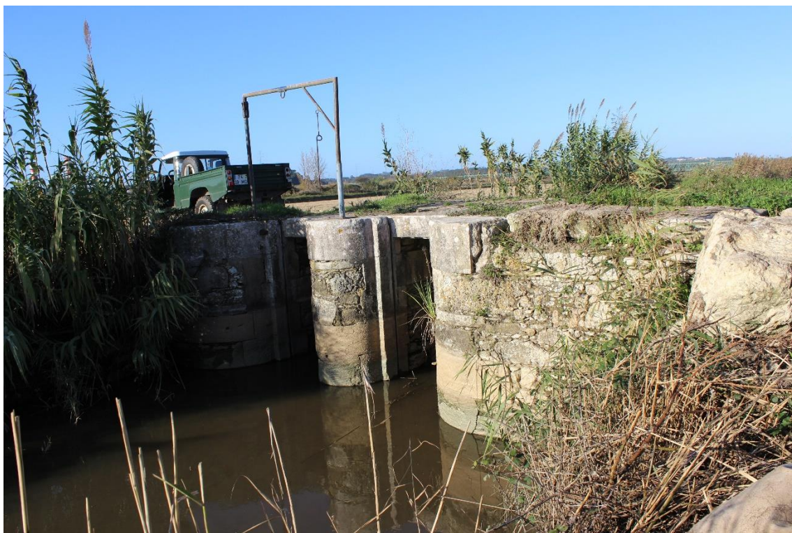
Figura 1 – Comporta de duas portas sobre a vala das Areias
