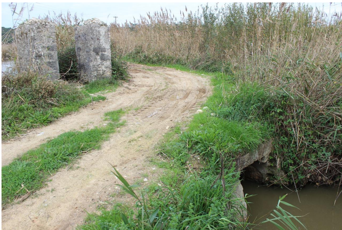
Figura 1 - Início da Vala Real na proximidade da estação elevatória do Bicanho. Na imagem a antiga comporta.
