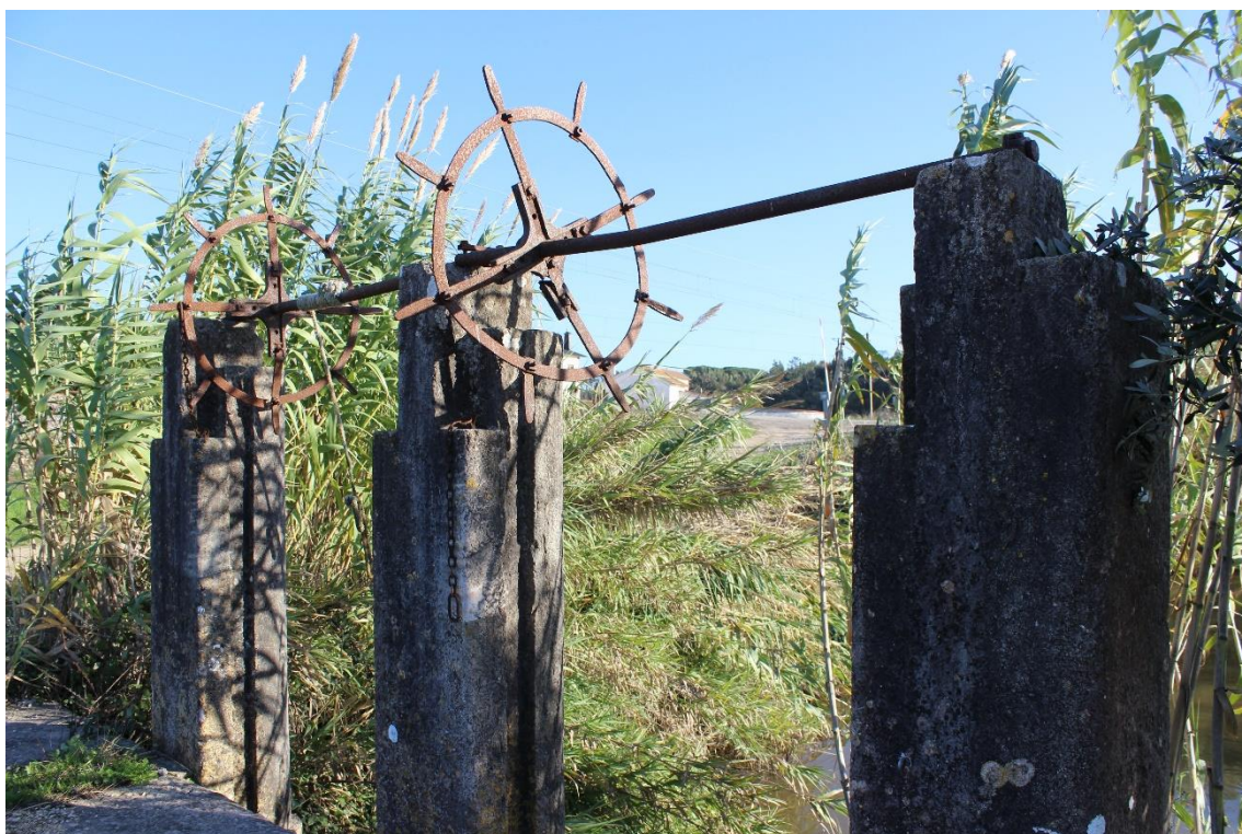
Figura 2 – Aspeto do engenho para elevação das portas.
