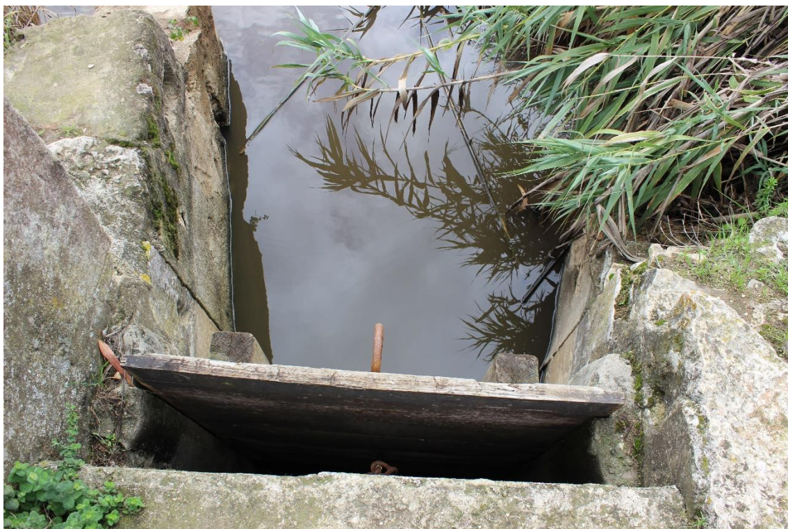
Figura 3 – Pormenor das calhas e da porta de água.
