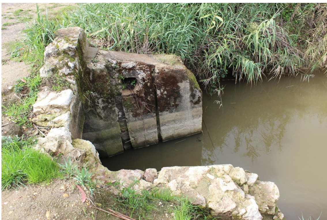
Figura 4 – Pormenor do cubo a montante apresentando dupla calha .
