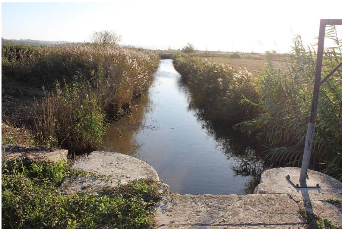
Figura 3 – Perspetiva sobre a vala.
