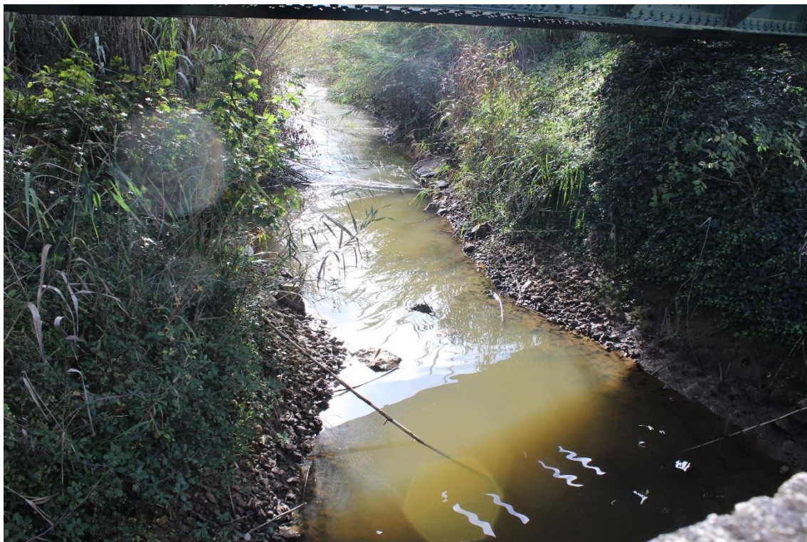
Figura 1 – Início da vala da Galegoa junto à linha férrea no Bicanho.
